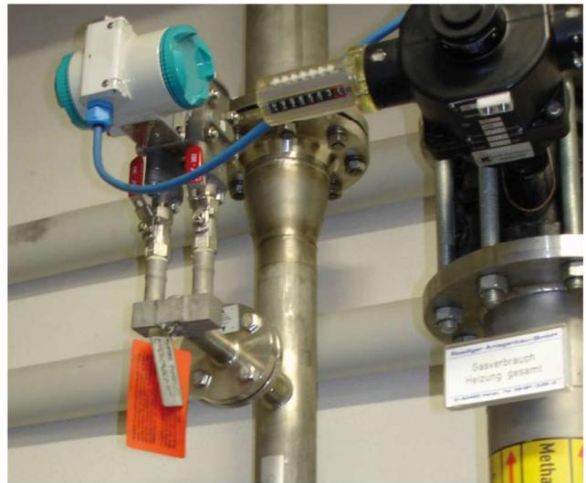
deltaflow für Biogasmengenmessung
