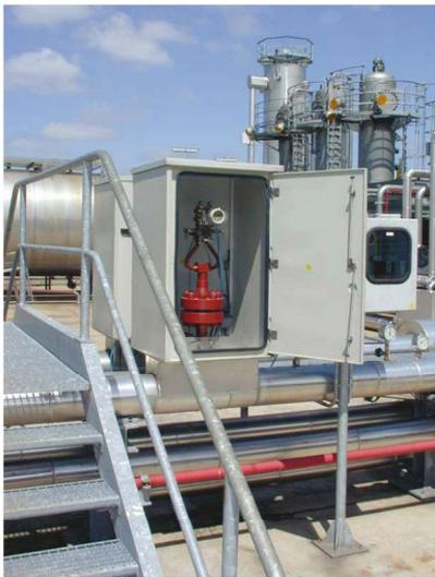
DF25HDD3 für verschmutztes Hochdruckerdgas hinter Bohrkopf
